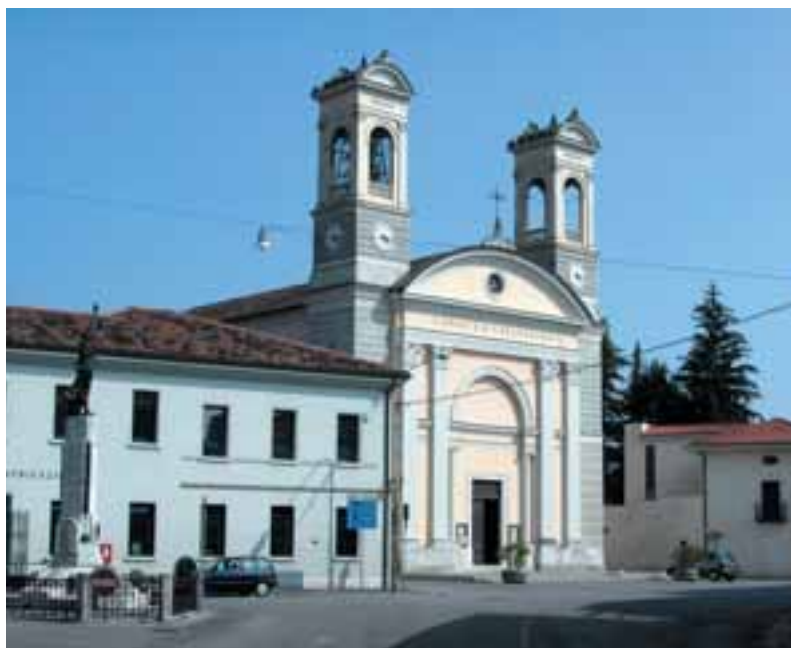
Casarsa della Delizia, località Versuta, Chiesa di Sant'Antonio abate
